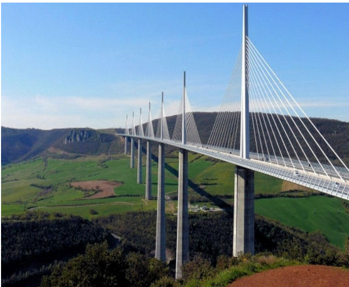
Viaduc de Millau
